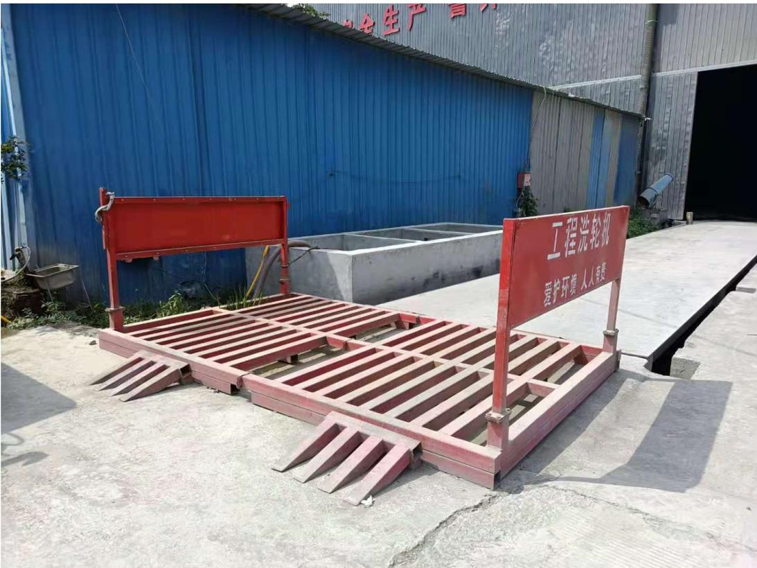
图 4-2 运输车辆洗车平台及清洗废水三级沉淀池
